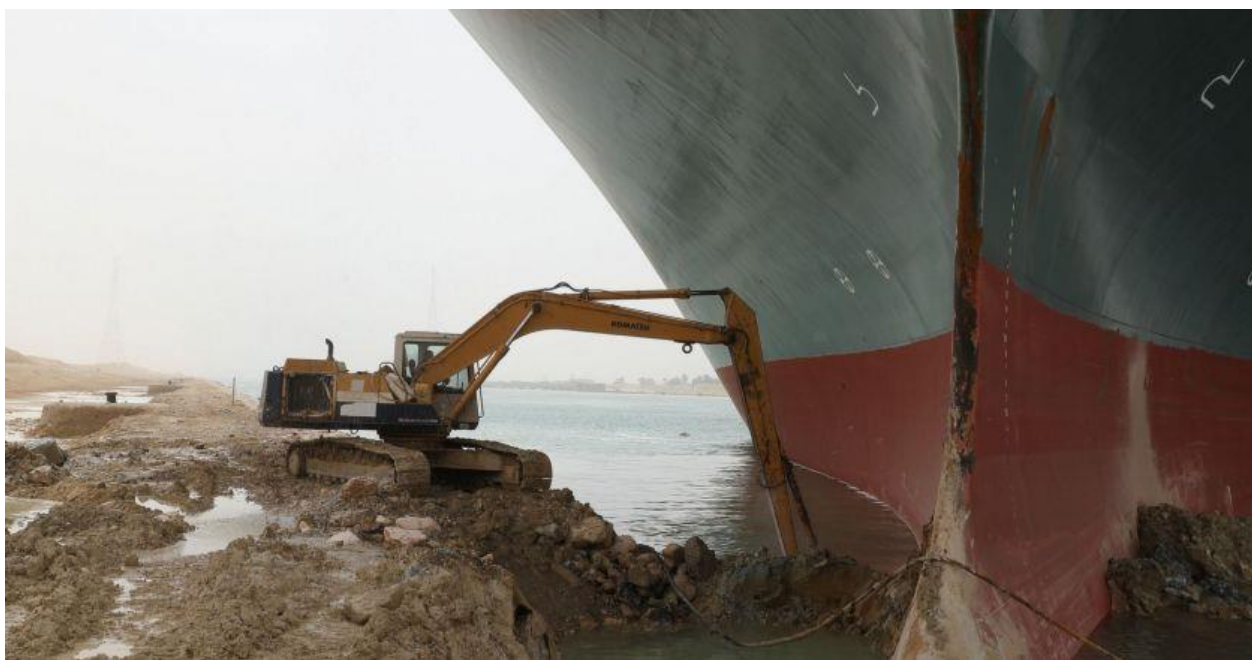
Pour désensabler l'Evergiven, il a fallu une dizaine de remorqueurs, des dragues pour creuser le fond du canal (20 000 tonnes de sables déplacées), et le profit d'une marée avec de forts coefficients. © Sipa Press
